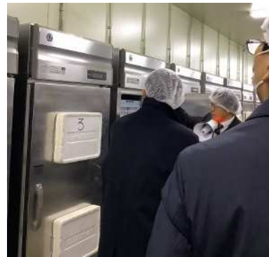
蓄冷材凍結庫 なのはな生協ではドライアイスの代わりに冷凍蓄冷材を使用しているので凍結させるための凍結庫が設置されています。
