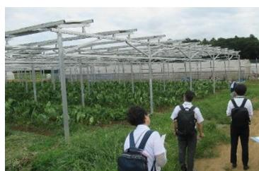
太陽光パネルの設置は地域住民へ丁寧に説明。農作業のしやすさ考慮し、パネルの高さや柱を設置。作物は、日照量を考慮して選択。
