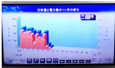
玄関に発電量をパネルで表示
