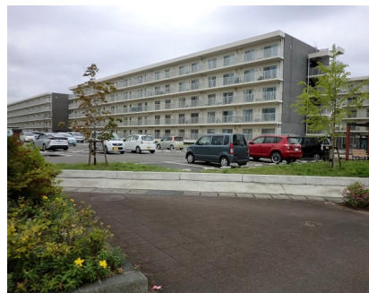
☎ 県の復興公営住宅は市内に5カ所。棟ごとに管理人と呼ばれる住民の代表がいます。
