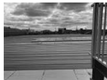
太陽光パネル
